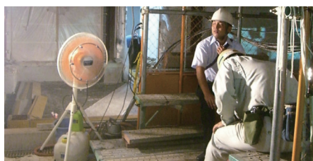
屋内(休憩所)(熱暑対策)
